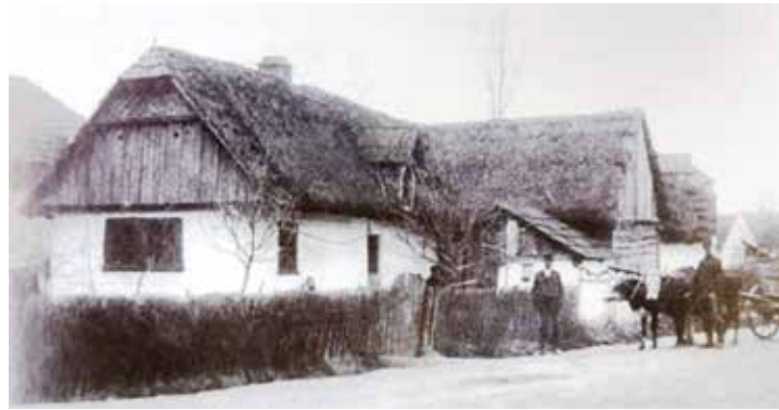
Lidové stavení u silnice ve Velkém Zboží
